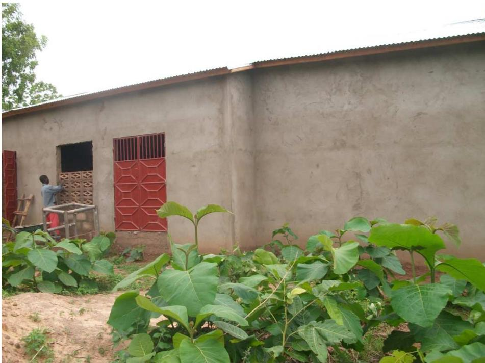
Photo 2: crépissage et fixation des claustrâts
